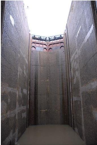
La photo ci-contre montre la porte de l'écluse de Réchicourt – le – Château, située sur le Canal de la Marne au Rhin, dans le département de la Moselle. Cette écluse géante, mise en service en 1964, remplace six écluses traditionnelles et permet le passage des bateaux en 30 minutes au lieu de 6 heures. Elle permet un dénivelé de 15,30 m.
